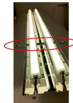
Zum Befestigen der LED Module bei Leuchten mit indirektem Lichtanteil (freischwebende Röhren) wird das Set (**Artikel-Nr. 6154**) benötigt. Es besteht aus 6 Metallstreifen (170 x 12 x 1 mm), 12 selbstschneidenden Schrauben und ist universell einsetzbar.
